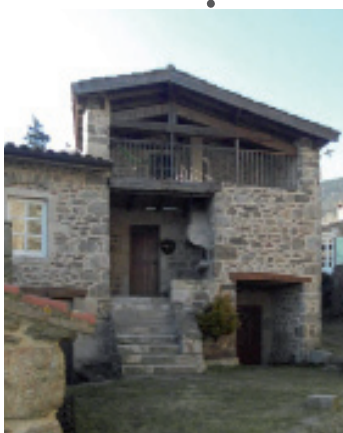
Exemple de débord de toiture
