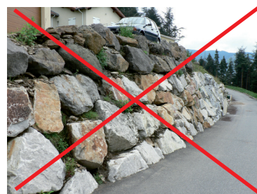
Exemple d'enrochements de type cyclopéen
