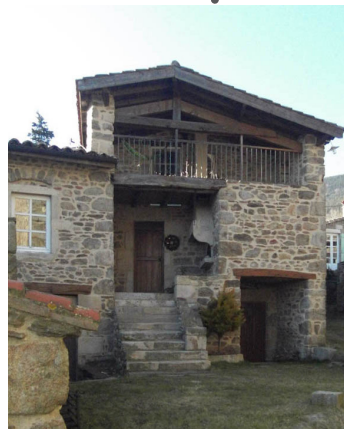
Exemple de débord de toiture
