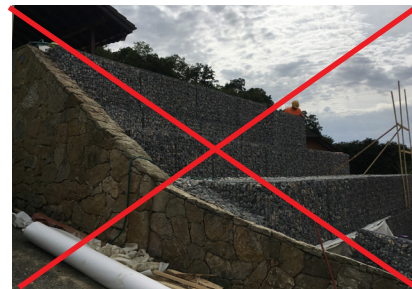
Exemple d'empilement de mur en gabions de hauteur totale supérieure à 2.00 mètres
