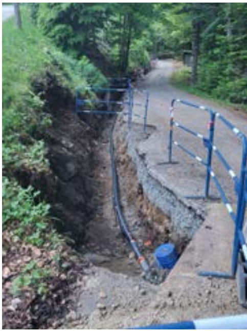
Travaux de canalisation du Mantel
