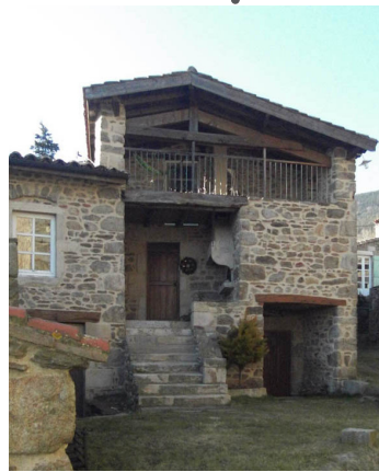
Exemple de débord de toiture
