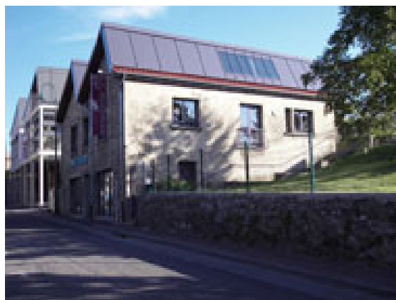
Exemple de toiture en shed
