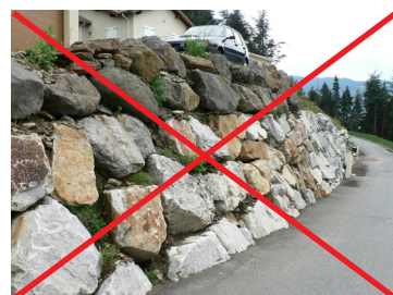
Exemple d'enrochements de type cyclopéen
