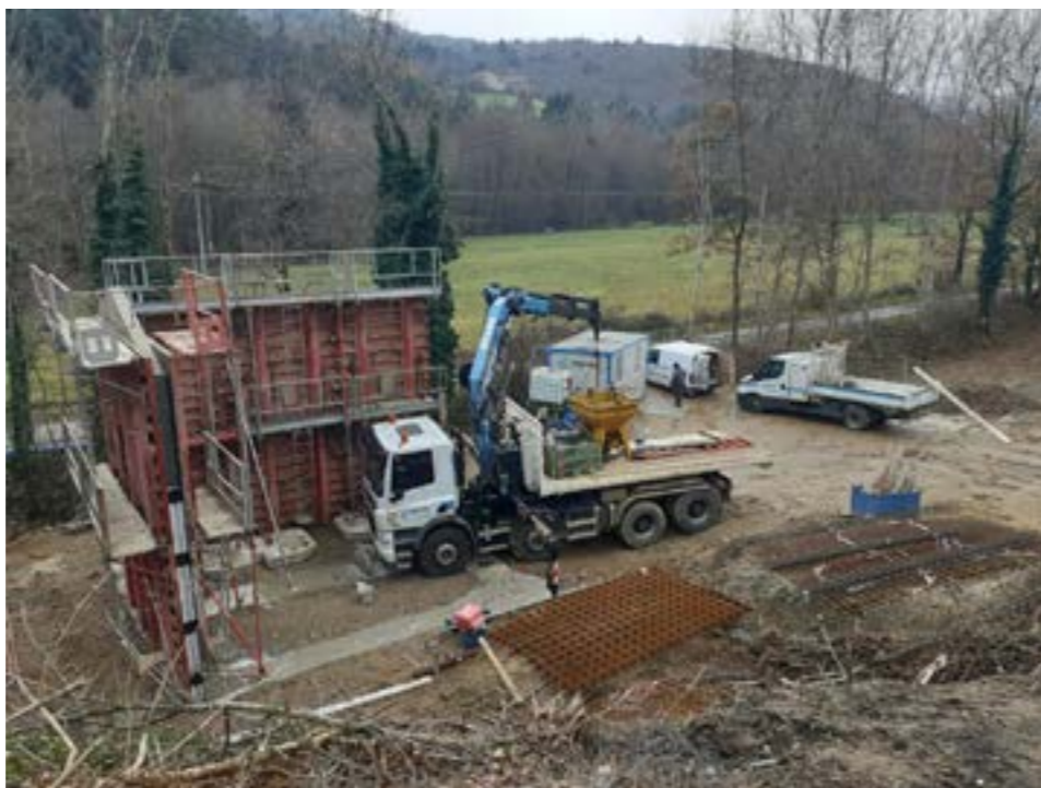
Construction du bâtiment de pompage commun
