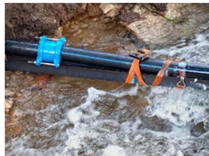
Réparation provisoire après les inondations du 17 octobre 2024
