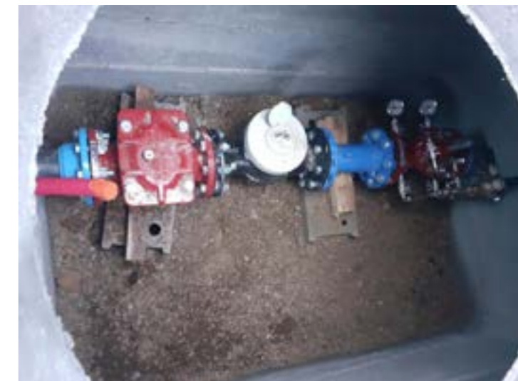
Vue à l'intérieur de l'ouvrage.
