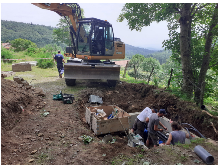
Nouvel ouvrage au départ du Mantel
