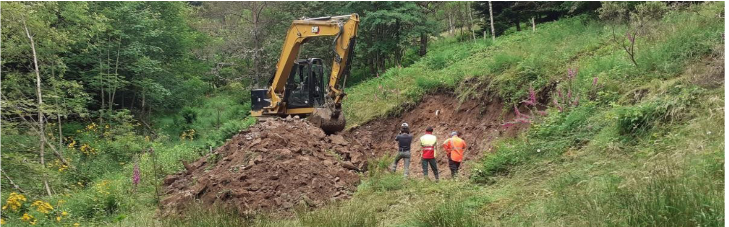
Rénovation du dernier drain au captage des sources du Mantel
