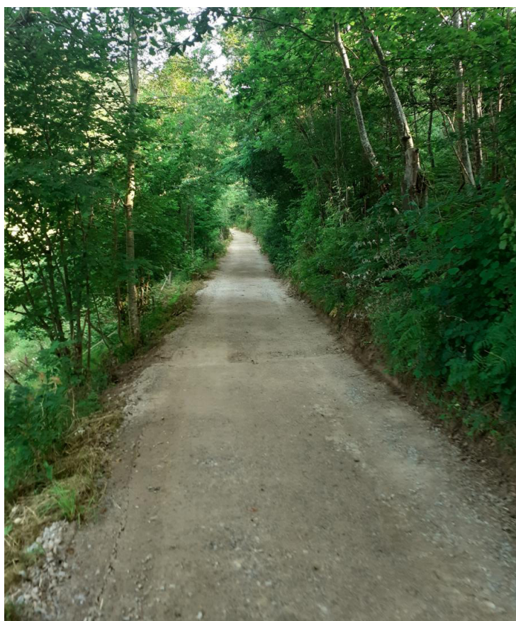
GR65 après les travaux.
