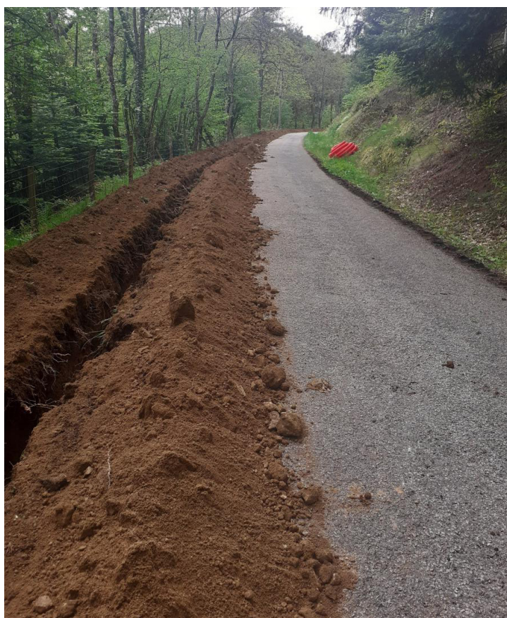
Enfouissement de ligne électrique entre Châtagnard et Combe Noire.
